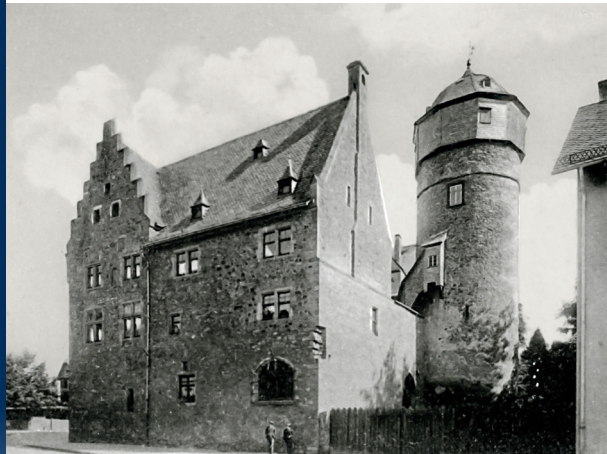
Das Alte Schloss nach dem Umbau 1905.
